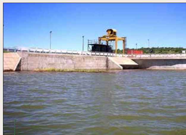
Von Bach Dam
